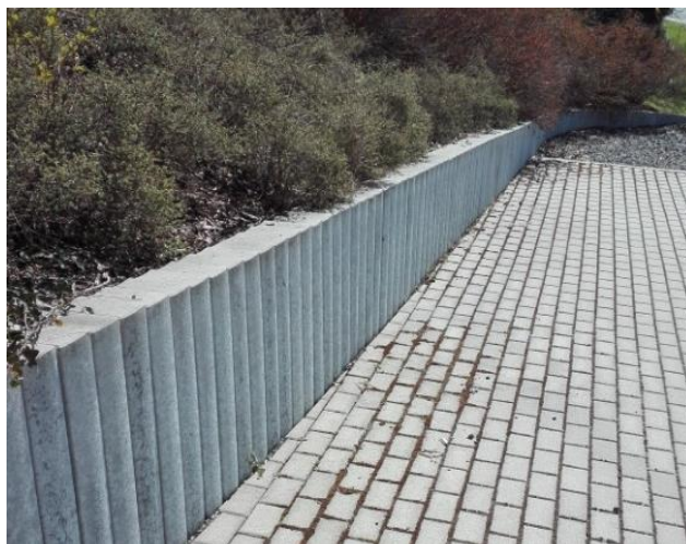
příklad betonové palisády u chodníku
