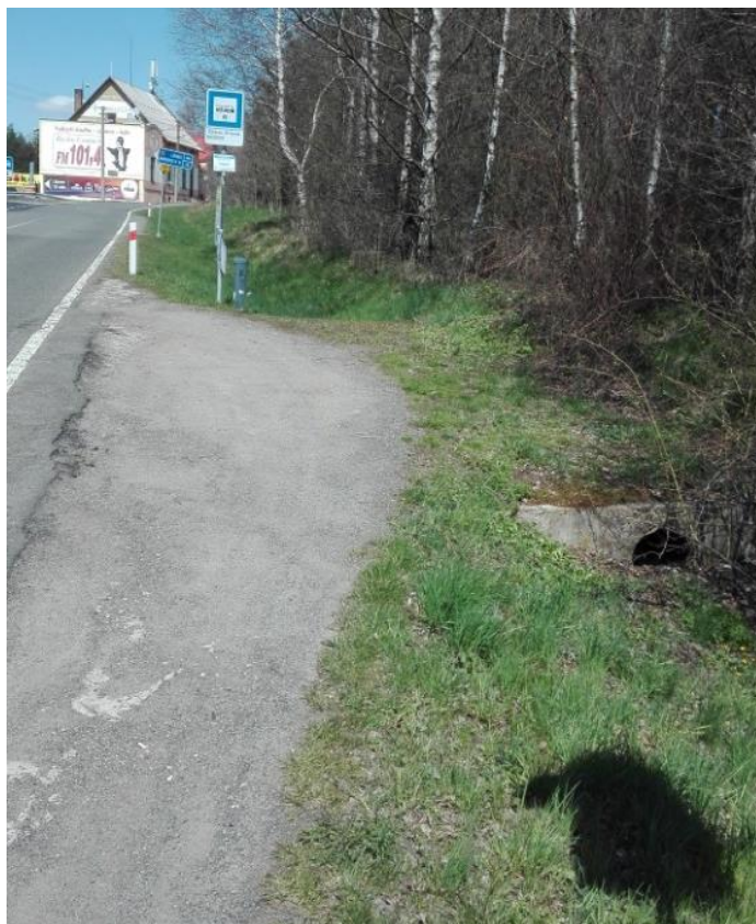
Pohled na začátek stavby, kde bude chodník 1 začínat - bude zde nová zastávka autobusu (a také zaústění nové dešťové kanalizace D1 do stáv. příkopu)
