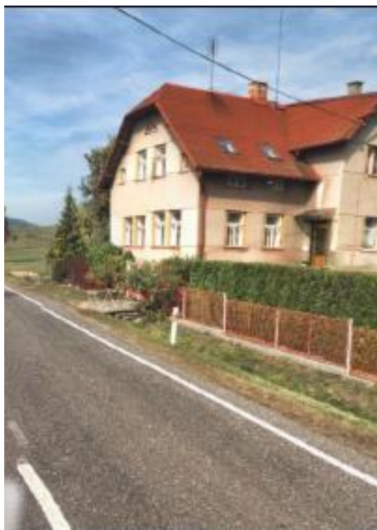
Pohled na konec trasy chodníku 8 u posledního RD
