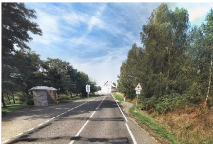
Začátek výstavby chodníku
